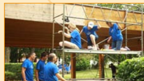
La structure en bois de la rotonde lasurée de frais
