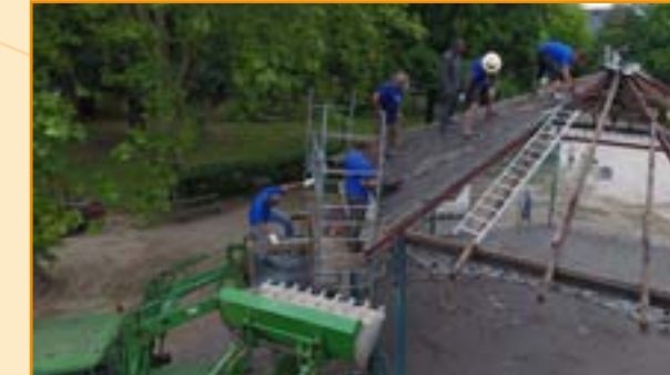
La toiture du kiosque démontée dans le cadre de sa restauration en cours (voir p 7)
