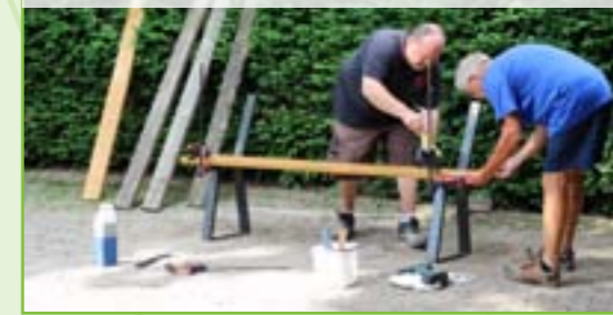
Les assises et dossiers de 25 bancs publics ont été démontés et remplacés. Les supports métalliques ont été quant à eux repeints.
