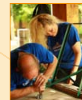
Les 120 garnitures de la rotonde remises en état
