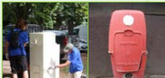
Même les transformateurs ont eu droit à une couche de peinture fraîche !
