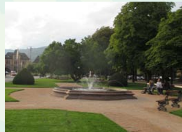
2/ Jardin de ville, rénovation de la fontaine
