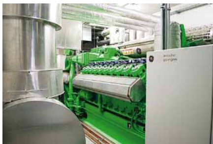
Bâtiment abritant la centrale de production d'électricité et de chaleur.
