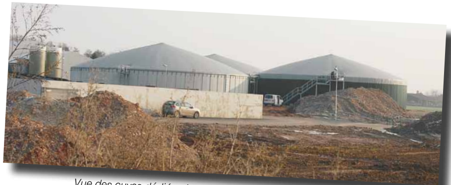
Vue des cuves dédiées à la "digestion" des matières premières.
