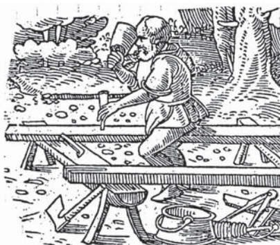
Dégrossissage des poutres
