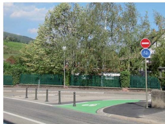
Avenue De Gaulle : les plots empêchent les automobilistes d'accéder par le haut à la Rue Wendling ; seuls les cyclistes y sont autorisés.
