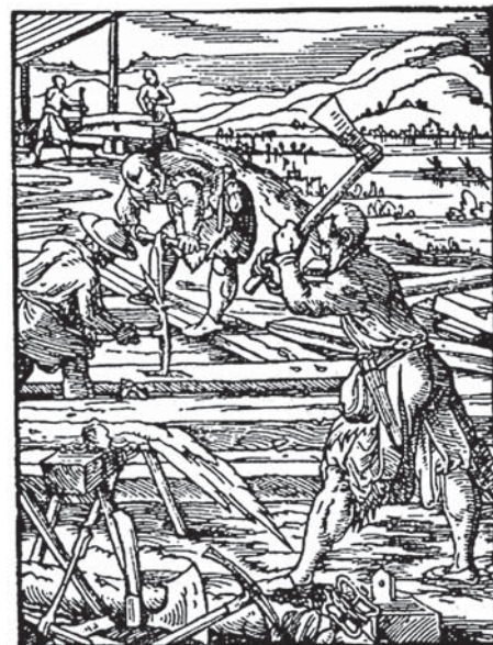
Mortaisage des poutres
