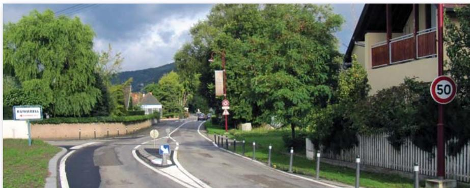
Les travaux de sécurisation de l'entrée de ville route de Colmar sont achevés. Les bornes provisoires indiquant le « tourne-à-gauche » qui permet de rejoindre la rue de Colmar ont été remplacées par une matérialisation en bordures de béton définitive. La chaussée est sensiblement rétrécie de ce fait. Les bas-côtés de la route, en partie affaissés, ont été consolidés dans le même temps. Avec le mini-gira-
