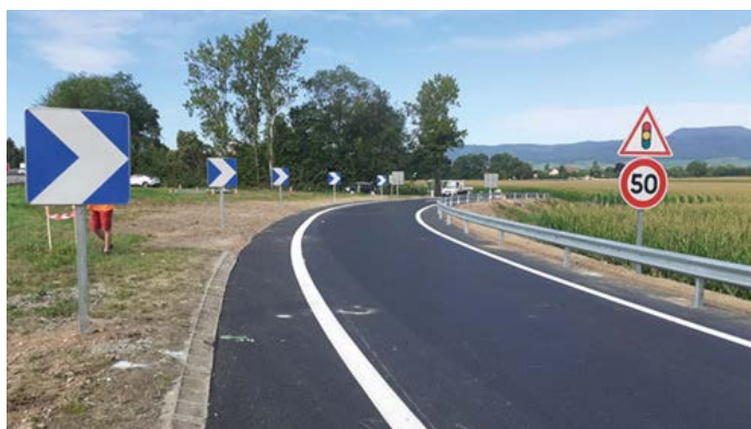
Aménagements de sécurité sur l'échangeur de Guémar pour 600 000 €
