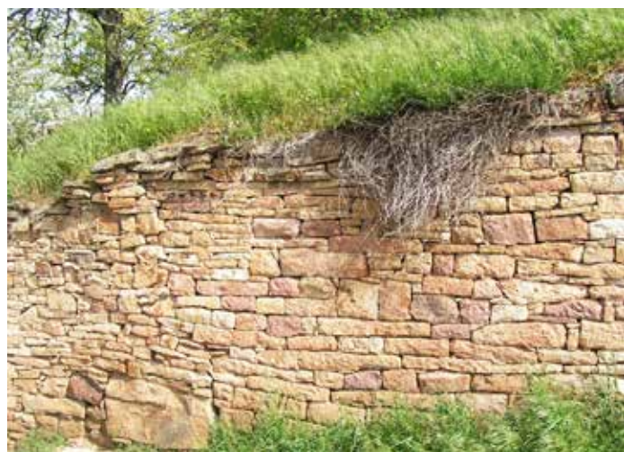
(Re) Construction de murets en pierres sèches
