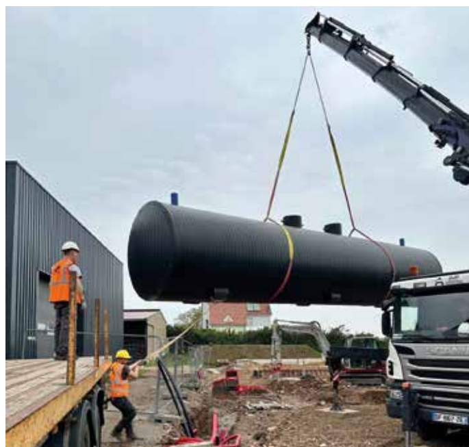
La cuve de rétention a été posée et enterrée le 9 mai dernier
