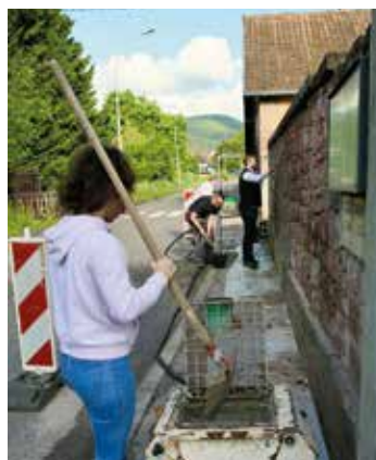
Atelier musée : décrépiage et jointage des murs en pierre
