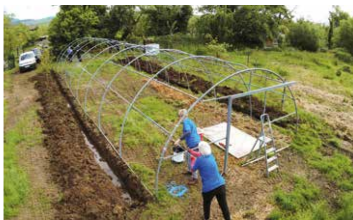
Jardin pédagogique : paillage, pose de grillage et bâche
