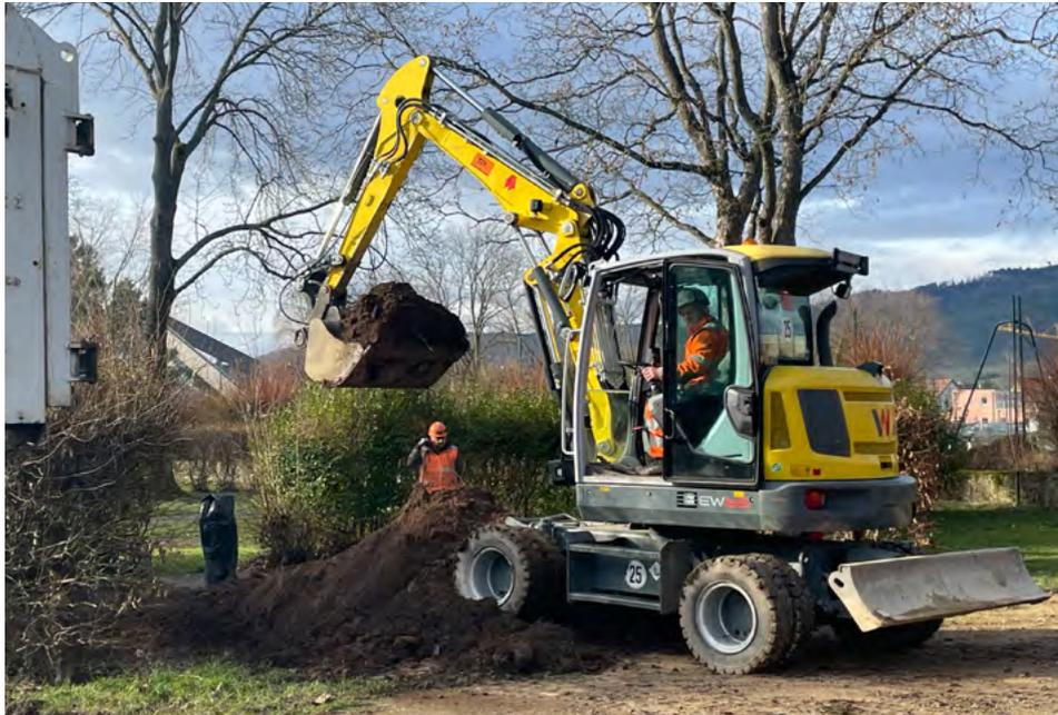
Les emplacements dédiés aux camping-cars ont été entièrement réaménagés. Le décaissement du terrain a permis de préparer une base solide et durable pour accueillir le nouveau revêtement. Du concassé calcaire a été répandu pour stabiliser le sol et éviter l'enlèvement des véhicules. L'entreprise Colas a réalisé ces travaux pour un coût de 40 000€ TTC.
