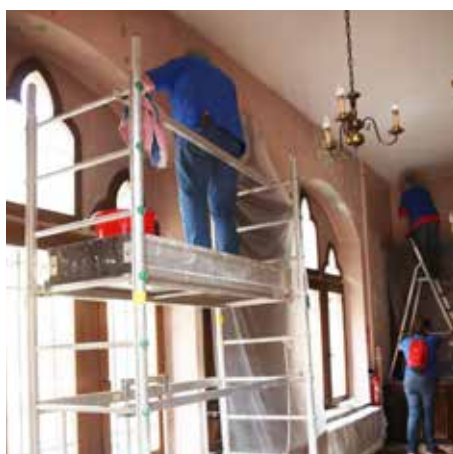
Eglise - Grattage de la peinture de la sacristie
