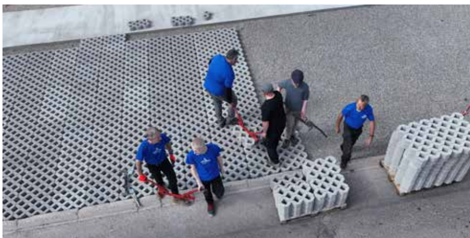
Rue de l'abattoir - Pose de pavés alvéolés sur l'aire de tri
