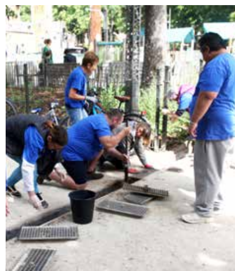
Nettoyage des rigoles d'évacuation d'eau
