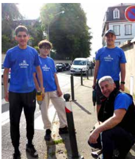
Réparation des potelets
