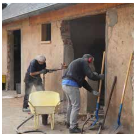
EVS Atelier-musée - Travaux de gros oeuvre pour aménager un atelier pour l'hiver
