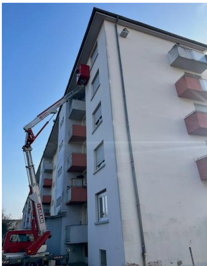
Figure 23 :Exemple de nichoir pour le Faucon crécerelle installé sur un bâtiment à Strasbourg, Meinau.
