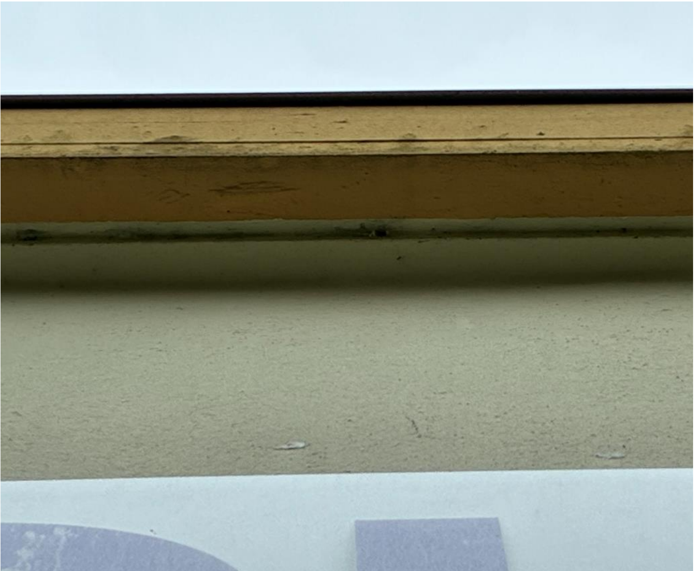
Figure 14 : Aspect extérieur sablière et couvertines
