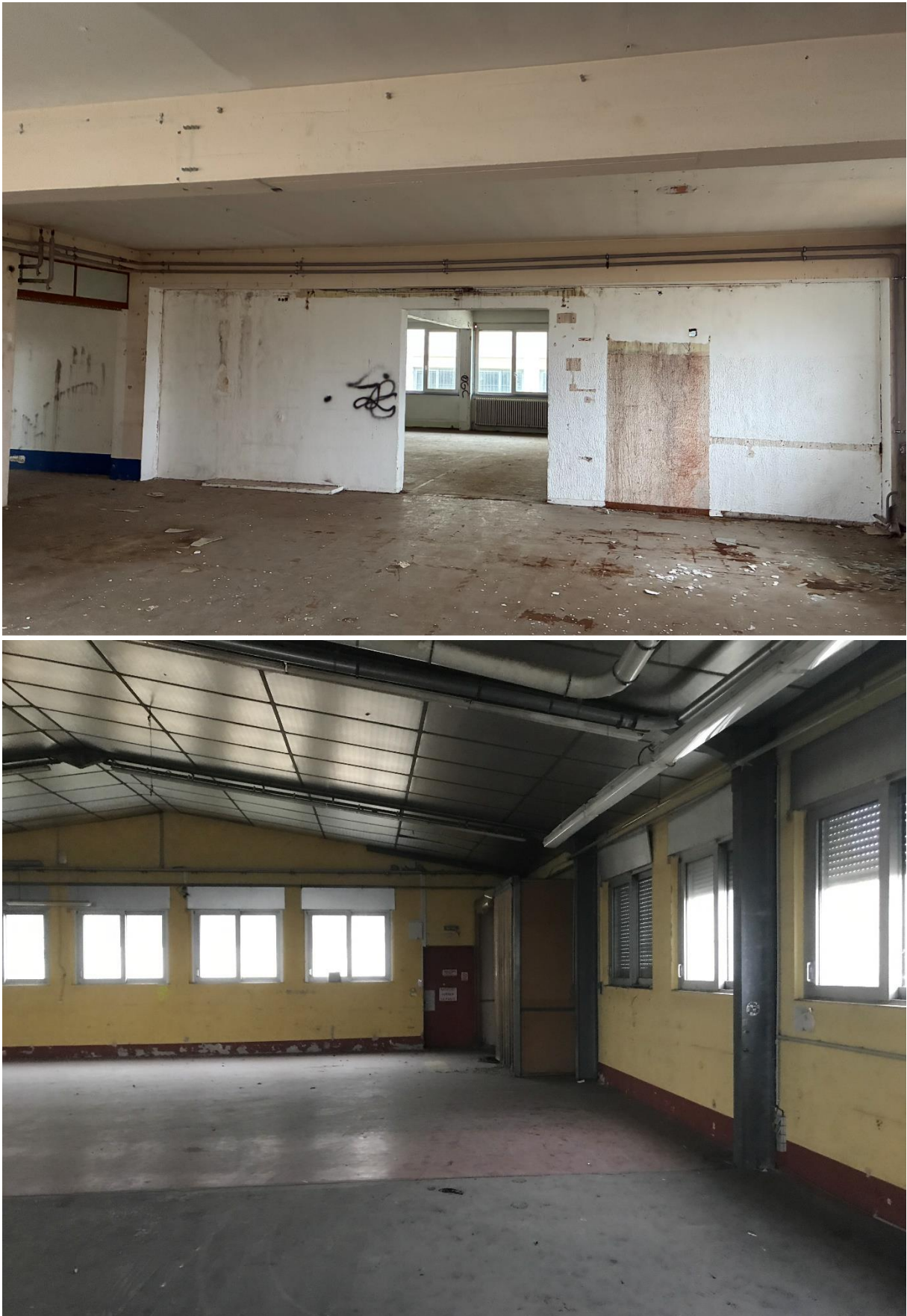
Figure 15 : Vue des cloisons intérieures
