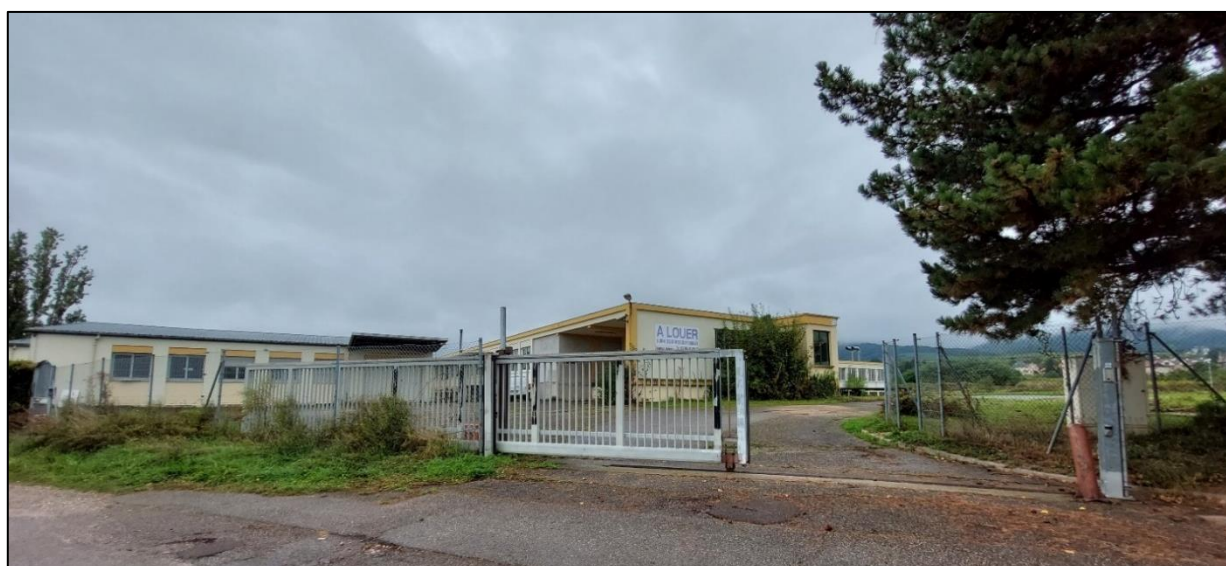
Figure 13 : Photographie de l'entrée du site d'étude – ECR Environnement, 23/09/2024
