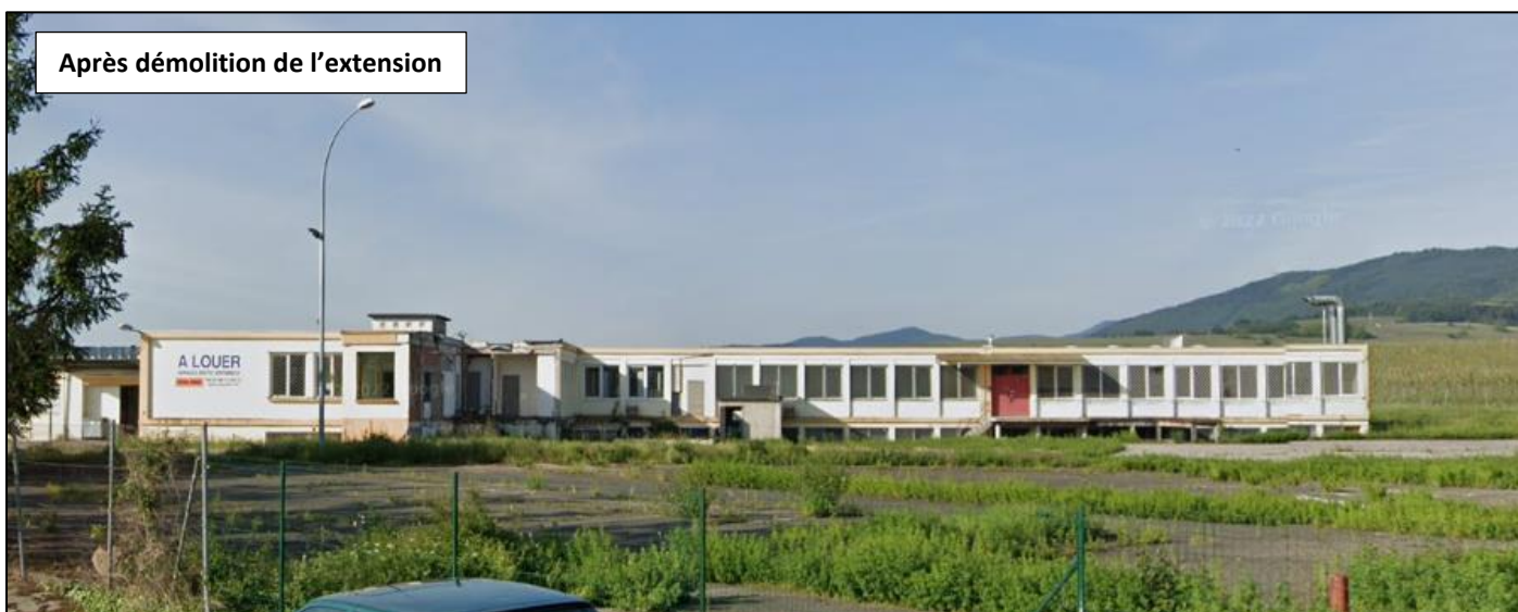
Figure 34 : Photographie du site d’étude en 2013 (haut) et 2019 (bas) – Google StreetView
