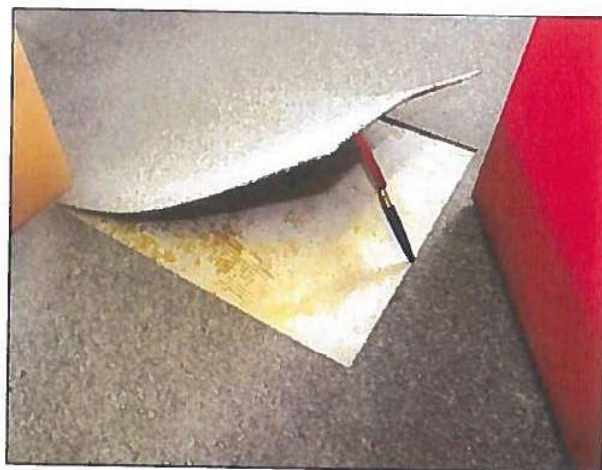
Revêtement de sol sur chape béton – bureaux – NON AMIANTE
