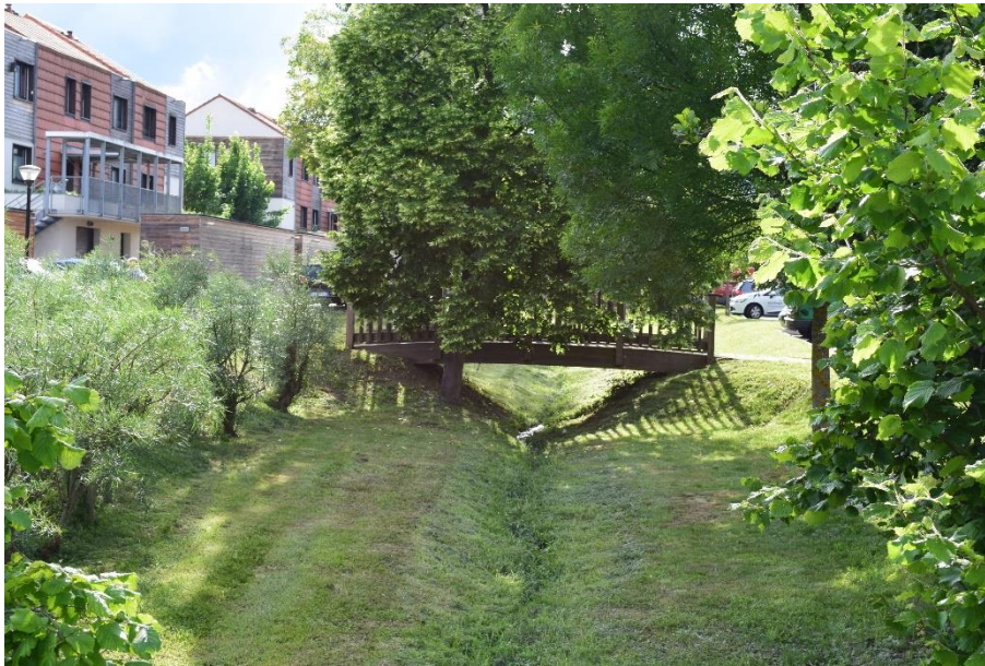
Le fossé aménagé dans la trame d'une extension contemporaine.
