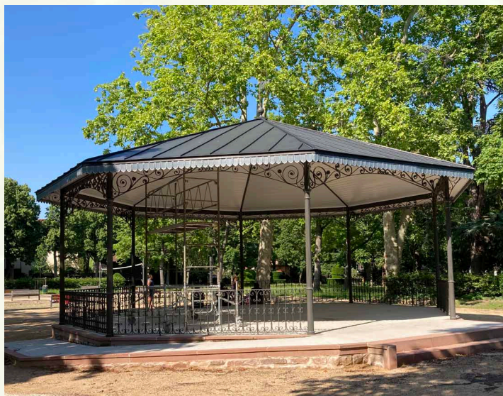
Rénovation du kiosque du Jardin de Ville en cours
