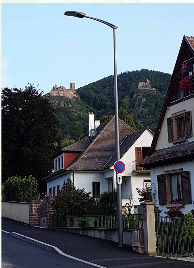
Lampadaires dans la rue du 3 décembre
