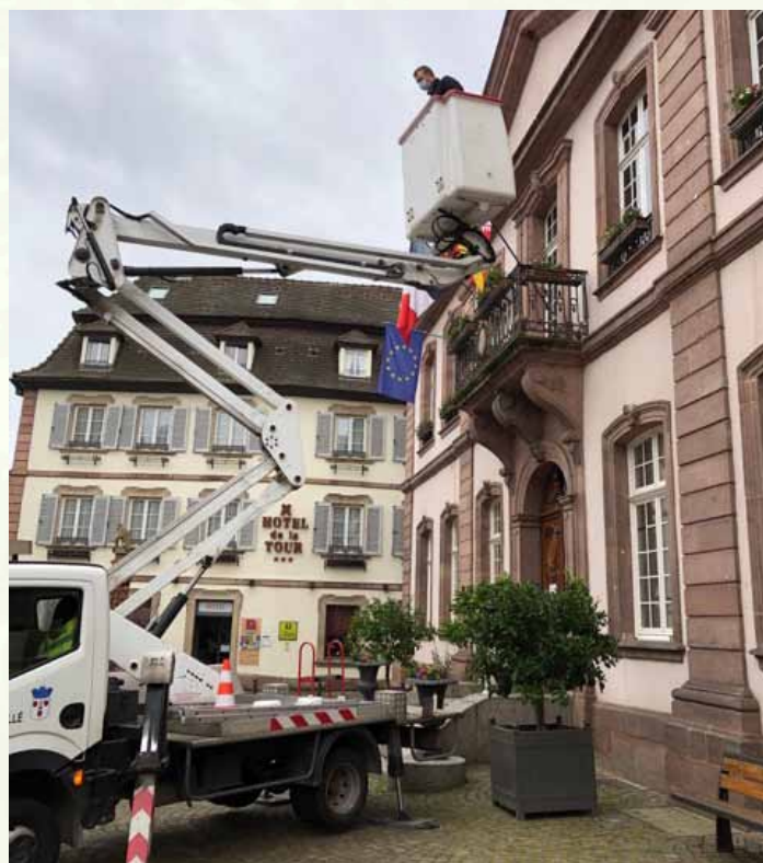
Installation des bacs à fleurs sur les rebords des fenêtres de l'Hôtel de Ville
