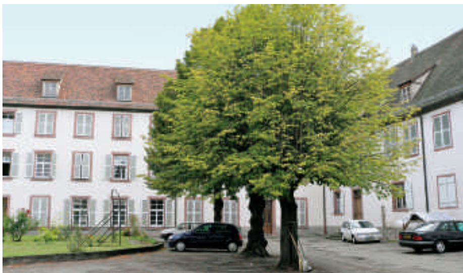
La cour et les bâtiments aujourd'hui.
