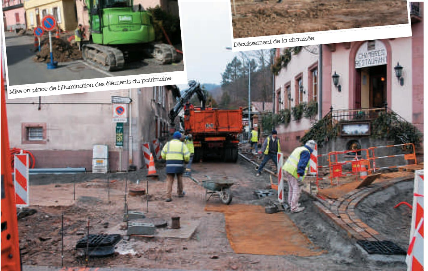
Construction des caniveaux et bordures et mise à niveau des ouvrages
